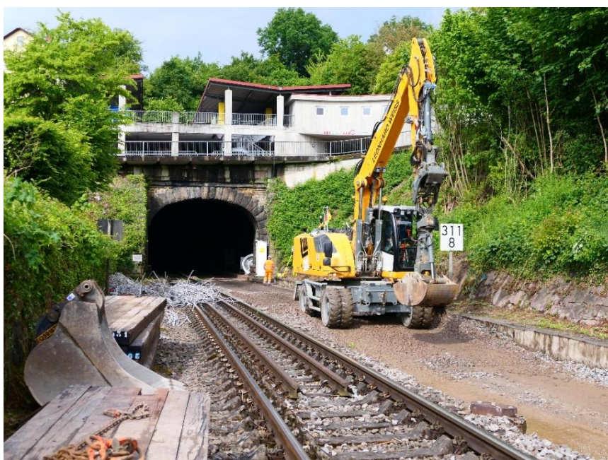
Bauarbeiten am Ostportal des Rappensteintunnel in Laufenburg (Baden); Quelle: DB InfraGO AG / Wolfgang Hugenschmidt
